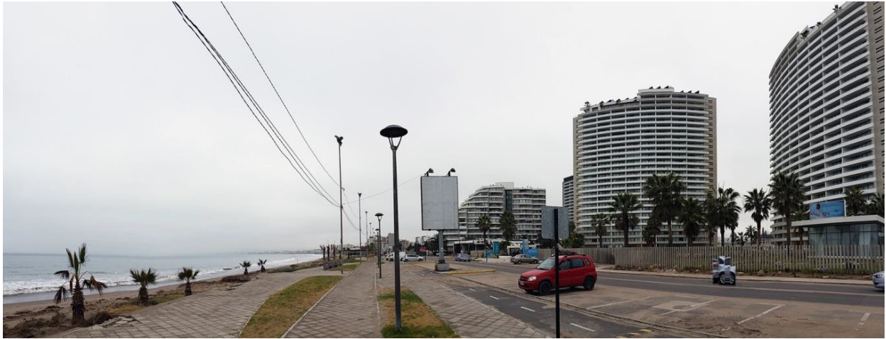
Fig. 4 Grandes conjuntos de edificación en altura en el borde costero de la bahía de Coquimbo.
